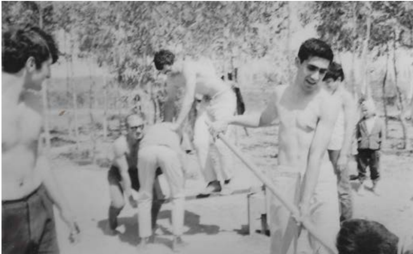
Deliminnet köyü: Sosyal Servis çalışması kapsamında Deliminnet köyünde okul inşaatı için briket yaparken
